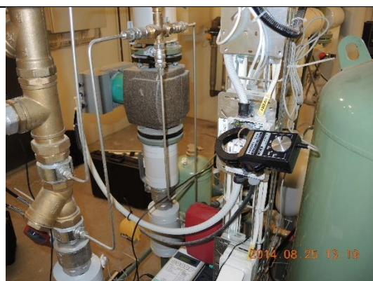
Bild 3.2.6 Loggning av ström till VS-pump med Mitec AT40 och strömtång. (Björnsonsgatan)
