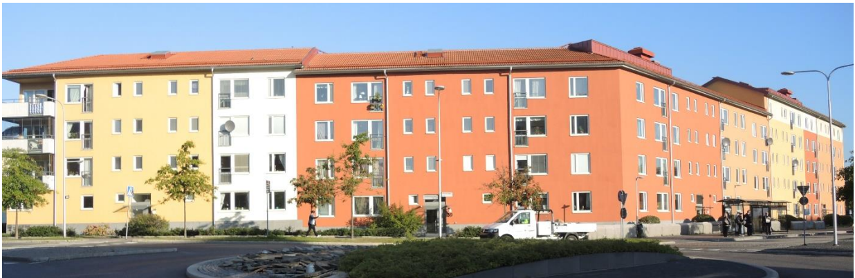
Lännavägen, Huddinge. Trapphus mot Lännavägen, Kommunalvägen och Rådsvägen.
