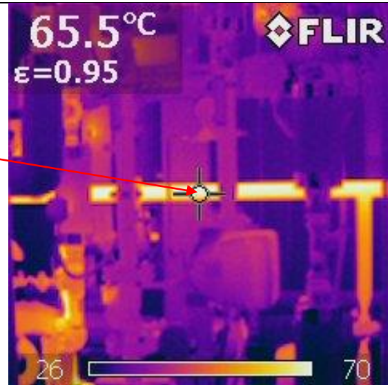
Bild 5.4.2 Yttertemperaturen på t ex värmerör till varmvattenväxlare är ofta minst 40°C varmare än omgivande rumsluft hela året, dvs 8760 timmar/år motsvarande 40 \cdot 8760 = 350\,000 gradtimmar per år!
