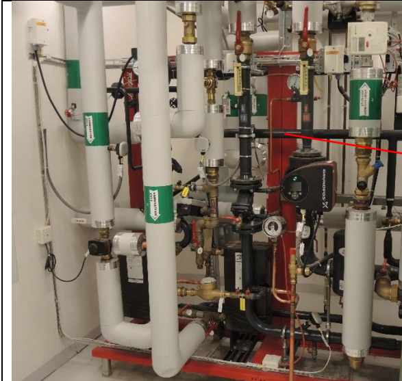
Bild 5.4.1 Fjärrvärmeundercentral med delvis oisolerade varma rör leder till onödigt stora värmeförluster och hög rumstemperatur.
