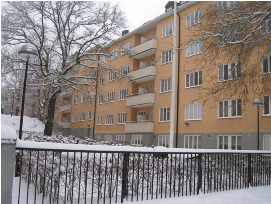
Bild 1. Balkonger indragna i fasad.
